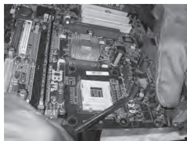
Ilustración 77: Desmontar un condensador. Foto: MAVDT
