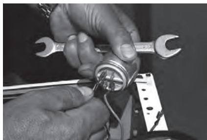
Ilustración 75: Sacar los cables del condensador. Foto: eag-leitfaden.
