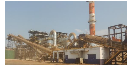
Mezcla con combustibles
