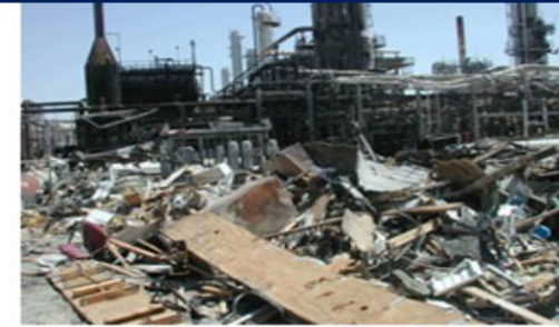
Texas City, USA, 2005 (Explosión nube de vapor) F: >15 I: ~180
