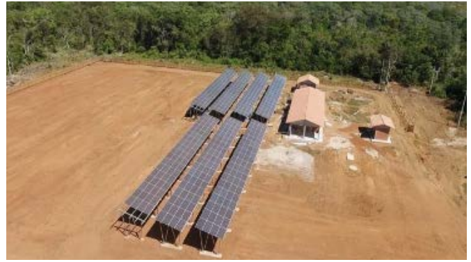
Desmonte de vegetación en una planta solar híbrida, (Solar - Diésel) con una potencia instalada de 168 KW pico, en Bolivia (Fuente: INEL Colombia, Proyecto El Remanso , Bolivia)
