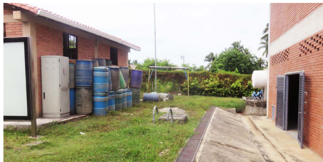
Derrame de diésel alrededor de la planta en Titumate Nótese la falta de impermeabilización del piso alrededor de la planta y la presencia de derrames directamente al suelo. (Visita de campo)
