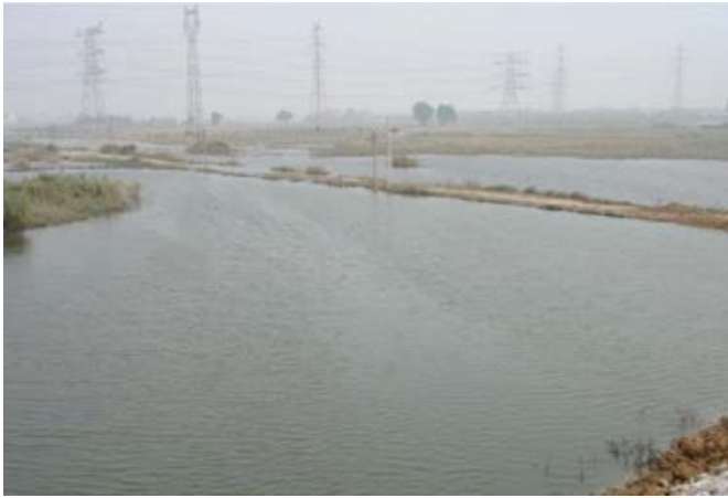
Línea de transmisión a través de un humedal
