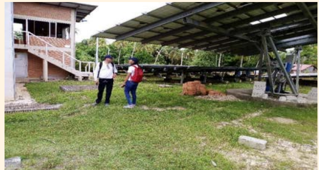
Instalaciones Administrativas y vista general del sistema Fotovoltaico
