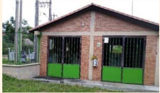
Caseta para el sistema diésel actualmente fuera de servicio
