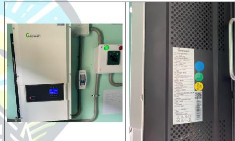
Descripción: Instalación de inversor solar de 8000/48V y sistema de monitoreo dentro de las instalaciones de ASOMCHO.
