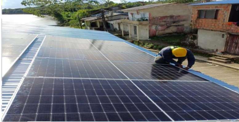
Figura 1. Instalación de paneles solares.
